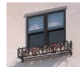
フラワーボックス 施工例
